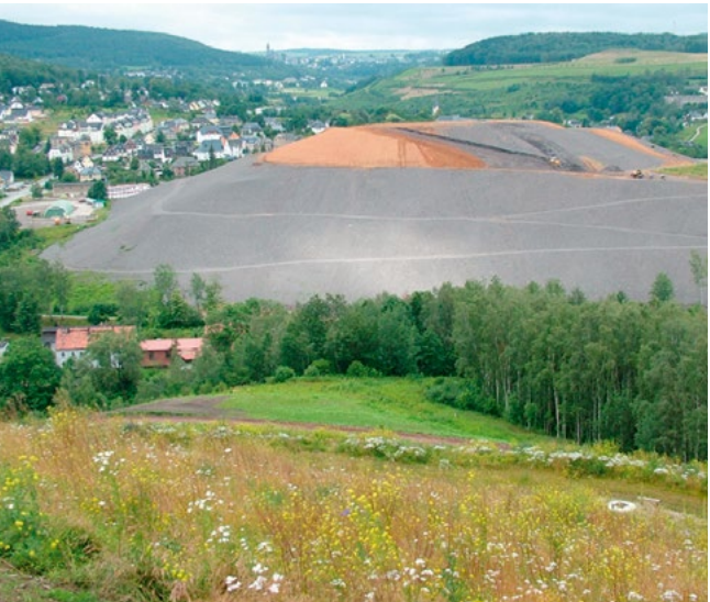
Profilierung und Abdeckung einer Halde des Uranerzbergbaus (C) LfULG
